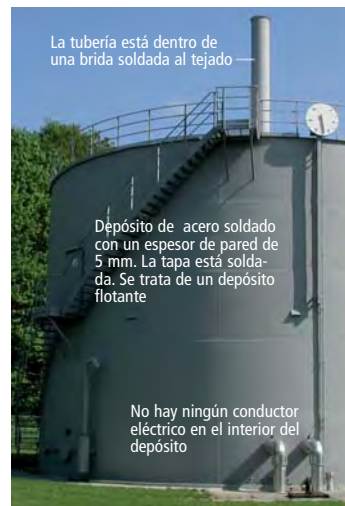
Fig. 9.3.8: Depósitos de acero soldado. (Fuente: Eisenbau Heilbronn GmbH).
