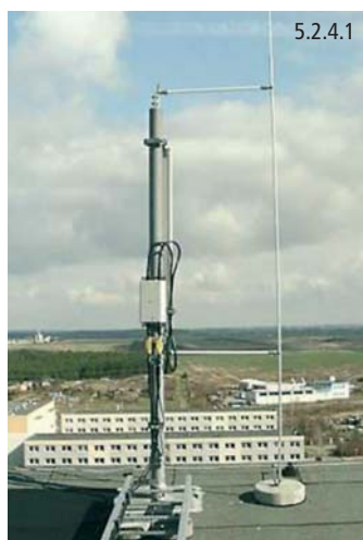
Fig. 5.2.4.1: Instalación captadora aislada con soportes distanciados.
