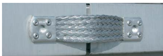
Fig. 5.1.3.4: Brida de puenteo.
