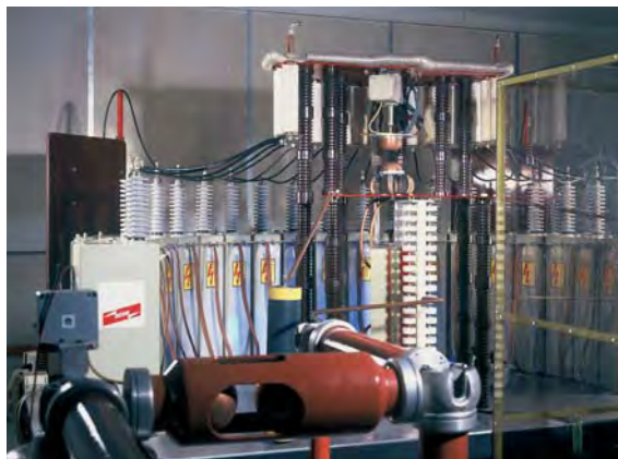
Fig. 9.16.1: Laboratorio de corriente de impulsos DEHN + SÖHNE. Corriente máxima de impulso tipo rayo 200 kA onda 10/350 µs.
