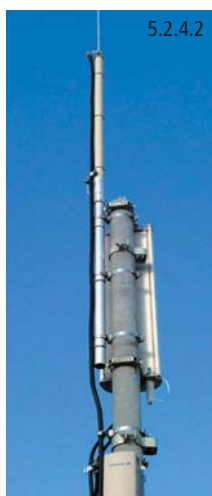
Fig. 5.2.4.1: Instalación captadora aislada con soportes distanciados.
