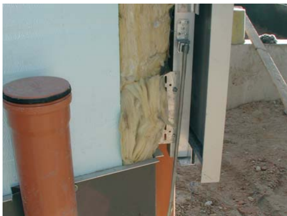
Fig. 5.2.2.2.3: Conexión a tierra de una fachada metálica.
