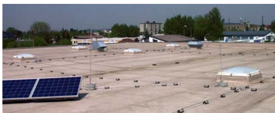
Fig. 5.1.3.3: Uso de puntas captadoras.
