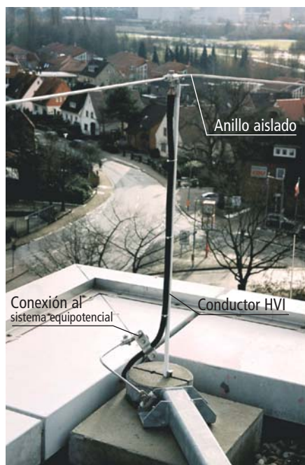
Fig. 5.2.4.3.3: Derivador de anillo aislado.
