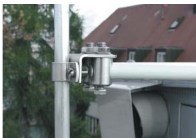
Fig. 5.1.8.5: Soporte de la punta captadora.
