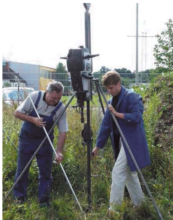
Fig. 5.5.4.2: Introducción de una toma de tierra de profundidad con ayuda de trípode y martillo neumático motocompresor.
