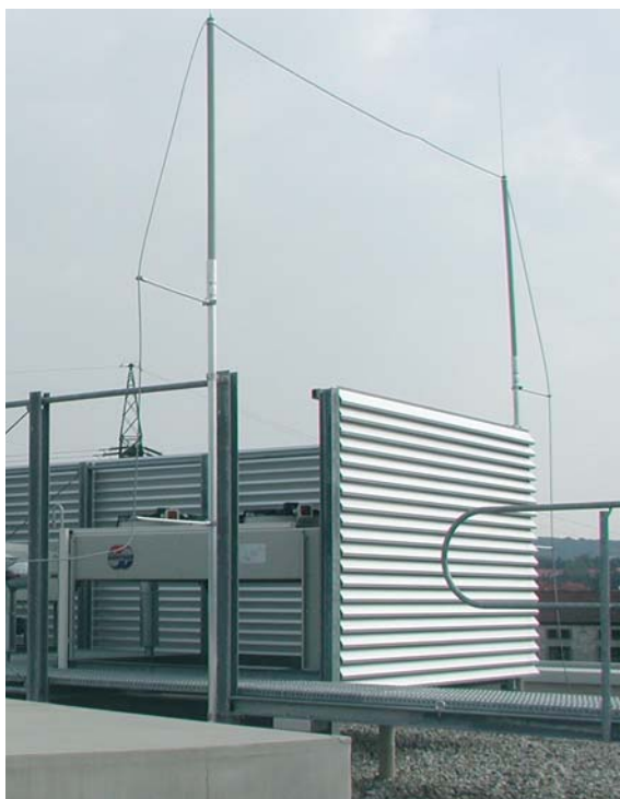
Fig. 5.1.8.14: Instalación captadora aislada con DEHNiso-Combi.
