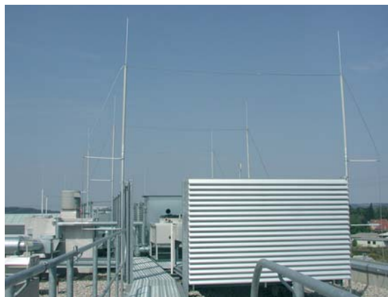
Fig. 5.1.8.12: Instalación captadora aislada con DEHNiso-Combi.
