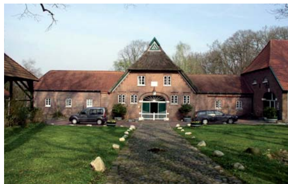
Fig. 5.1.5.4: Granja histórica con protección externa contra rayos. (Fuente: Hans Tormählen GMBH & Co K.G.).
