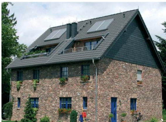
Fig. 5.1.2.4: Edificio con una instalación fotovoltaica. Fuente: Blitzschutz Wettingfeld, Krefeld.
