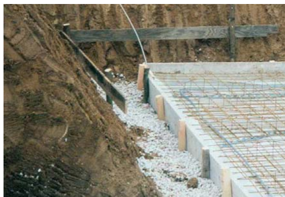
Fig. 5.5.2.4: Aplicación de tomas de tierra de cimientos.
