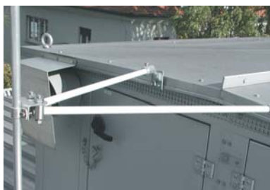
Fig. 5.1.8.4: Soporte angular para punta captadora.
