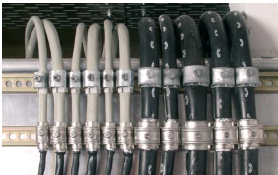
Fig. 6.3.3 Sistema de conexión de blindaje SAK capaz de soportar corrientes de rayo.
