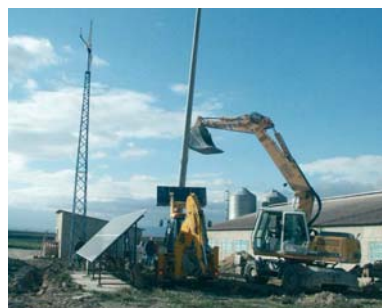
Fig. 5.1.8.9: Instalación de un mástil telescópico de protección contra el rayo.
