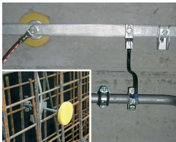
Fig. 5.5.2.8: Punto fijo de toma de tierra.
