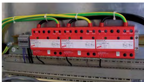
Fig. 9.16.4 Aplicación del descargador de corriente de rayo coordinado modelo DEHNbloc Maxi para sistemas 400/690 V TN-C.
