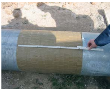
Fig. 5.1.8.8: Protección suplementaria contra la corrosión en la zona de transición, mediante cinta anticorrosiva para aplicación bajo tierra.
