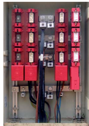
Fig. 8.1.6.6: Descargador de sobretensiones NV NH Tipo 2 para instalación en bases de fusibles NH.
