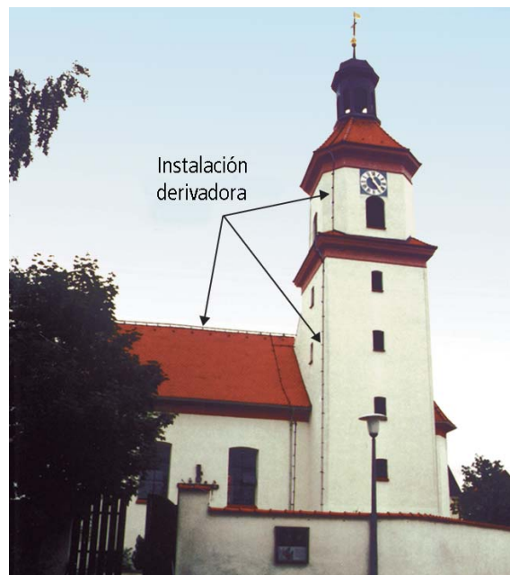
Fig. 5.1.9.1: Tendido de los derivadores en una torre de iglesia.
