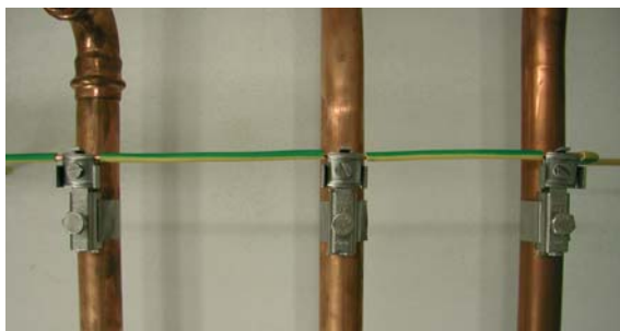
Fig. 6.1.6 Compensación de potencial con cableado de paso.
