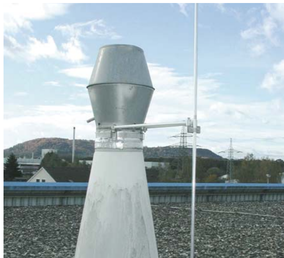
Fig. 5.1.8.3: Punta captadora con soporte distanciador.
