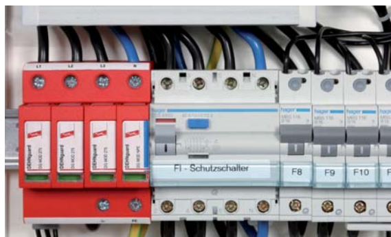
Fig. 7.7.2.3: Descargador multipolar de sobretensiones DEHNguard MTT.
