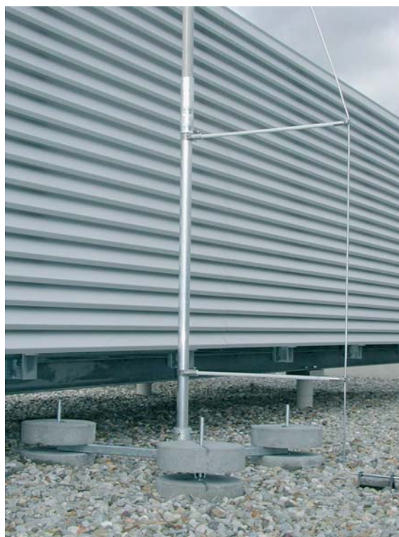
Fig. 5.1.8.11: Trípode para tubos auto soportados aislados.
