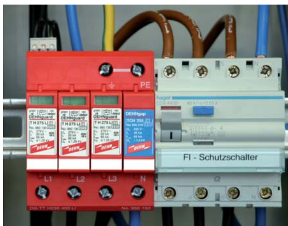
Fig. 7.8.1.2: DEHNGuard TT H LI – Descargador multipolar de sobretensiones con indicación de estado de funcionamiento.
