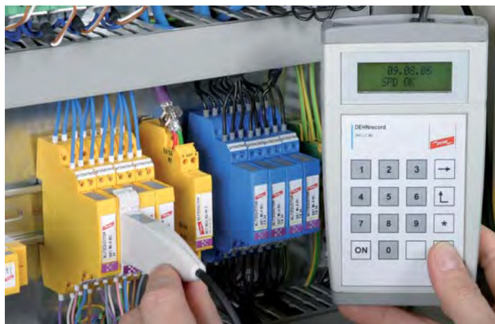
Fig. 9.3.12: Módulos de descargador combinado con LifeCheck.
