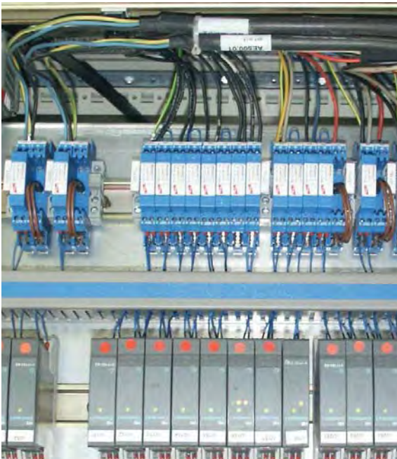
Fig. 9.15.6: BCT MOD MD EX 24 para circuitos de medida autoseguros.
