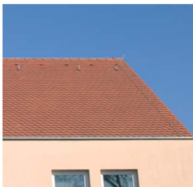
Fig. 5.1.2.1: Instalación captadora sobre tejado a dos aguas.
