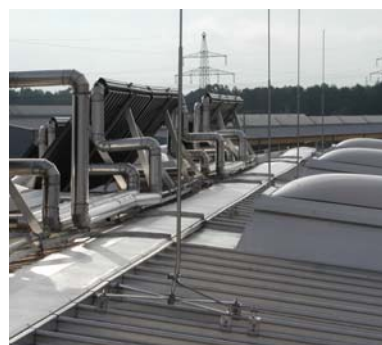
Fig. 5.1.4.7: Punta captadora para un lucernario en un tejado con junta redonda.
