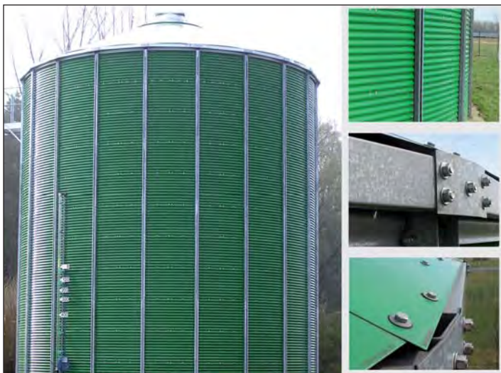
Fig. 9.3.6: Depósito fermentador de planchas de metal atornilladas.
