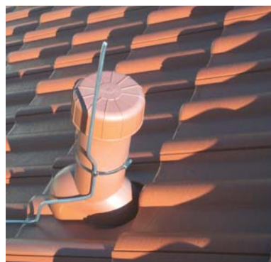
Fig. 5.1.2.3: Elementos captadores adicionales para tuberías de ventilación.
