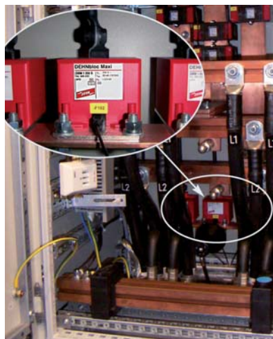
Fig. 8.1.6.5: DEHNbloc Maxi S: Descargador coordinado de corriente de rayo para embarrados con fusibles previos integrados.
