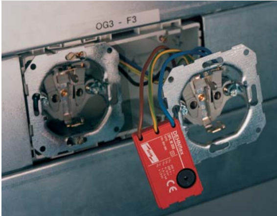
Fig. 7.7.2.2: Dispositivo de protección contra sobretensiones para circuitos finales, DEHNflex M.
